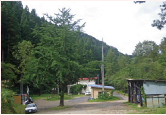
▲現在の管理棟(昭和57年建設)
